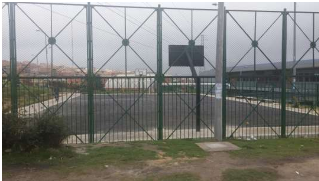
En el área de estacionamiento se construye una cancha múltiple, cambiando el diseño original de lo aprobado en la licencia.
