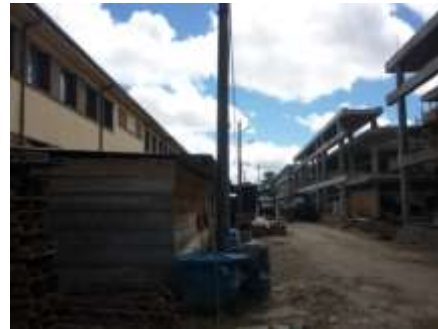
Vista general de los dos frentes de trabajo que se han implementado durante la ejecución de la obra.
