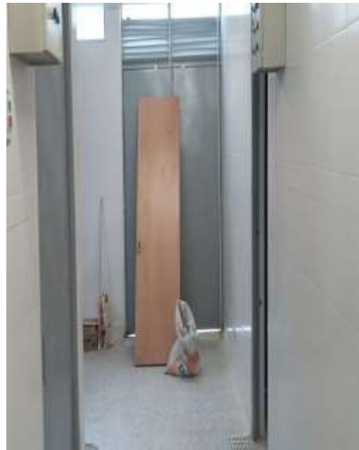
Cuarto frío, el cual no está en funcionamiento.
