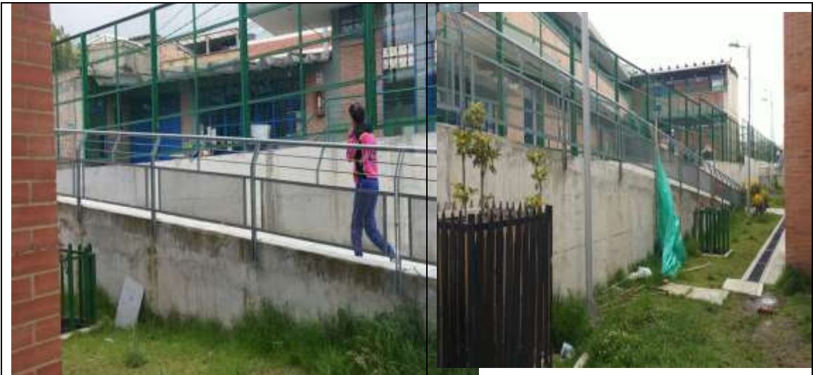
Existe construcción lateral (Sede A del antiguo Colegio), la cual se acondiciona para la primera infancia. Pese a no estar incluida en la licencia se construye esta rampa, la cual conduce a esta instalación.
