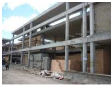
Avance de la obra en el frente de trabajo de: La construcción nueva para el bloque de aulas, en su etapa de estructura desarrollada con el sistema de porticos en concreto reforzado, para tres niveles.
