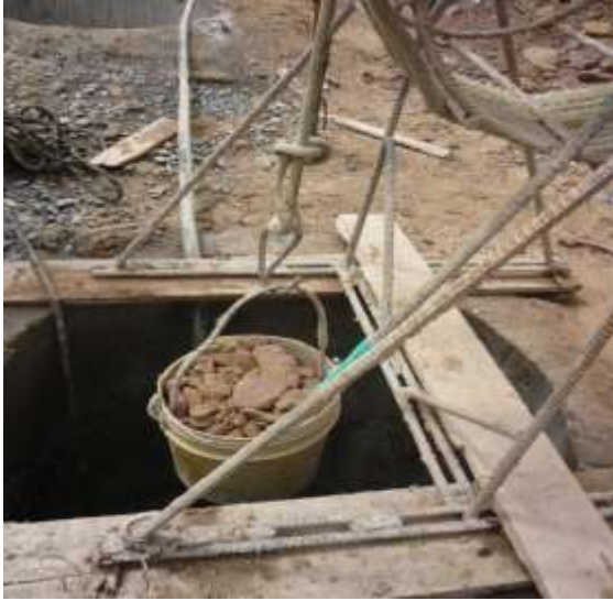
Muestreo y medición del material extraído a través del anillo caisson.
