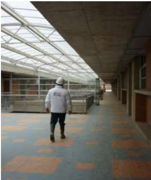
Al interior de la construcción del establecimiento educativo, se requirió como actividad complementaria dentro de las obras adicionales la instalación de la reja de cerramiento para protección de las aves a lo largo de la cubierta del quinto piso.
