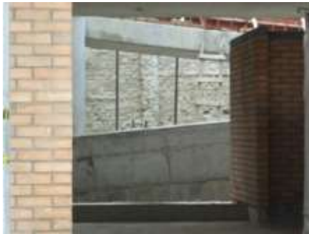
Detalle del avance en la mampostería en el área de la construcción nueva - bloque de aulas.
