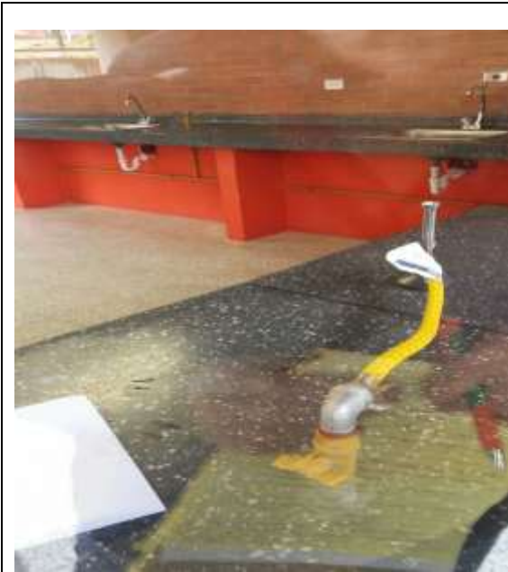
Salones de laboratorio, los cuales cuentan con punto de gas, pero no está en funcionamiento todavía
